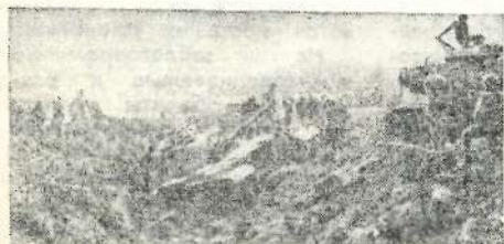
Рис. 5. Попытка на танке преодолеть ров, устроенный взрывным способом
